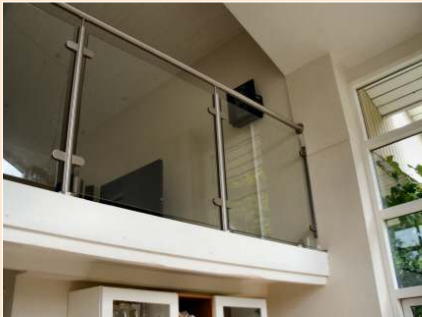
Fig.10 Hems rækværk værn, i lamineret hærdet sikkerhedsglas. Crosinox rustfrit stål hems balustre. Crosinox rustfrit stål hems håndliste.
