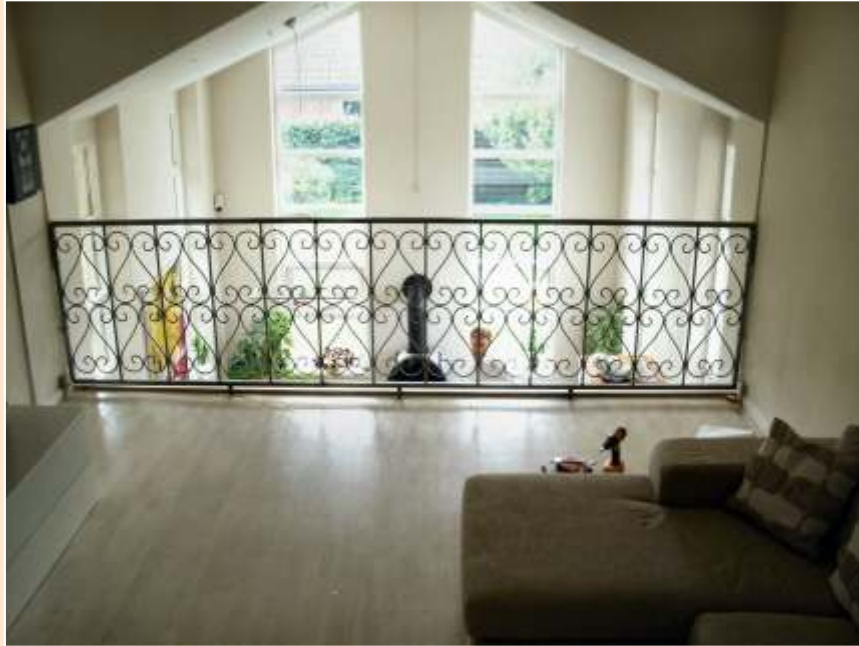
Fig.3 Hems rækværk, på åben indskudt etage, Hems- gelænder, rækværk, stakit, hegn, af-monteres og udskiftes med:
