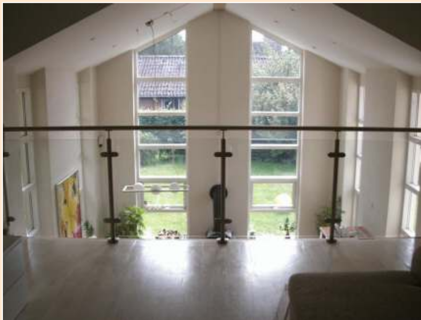
Fig.4 Hems gelænder, rækværk i rustfrit stål & glas:
